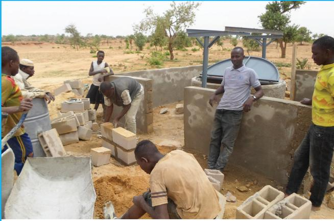
erreicht worden ist, lässt man den Brunnen volllaufen und das Wasser wird drei Tage lang aus dem Brunnen gepumpt, um ihn zu spülen. Jeder Brunnen hat zwei Deckel, einen betonierten Boden und ist von einer Mauer mit einer Zugangstür umringt, um das Vieh fernzuhalten. Außerhalb der Umzäunung ist ein Abfluss zu einem Trog angebracht, aus dem das Vieh trinken kann und die Bauern Wasser für ihre Felder in der Umgebung des Brunnens schöpfen können.
